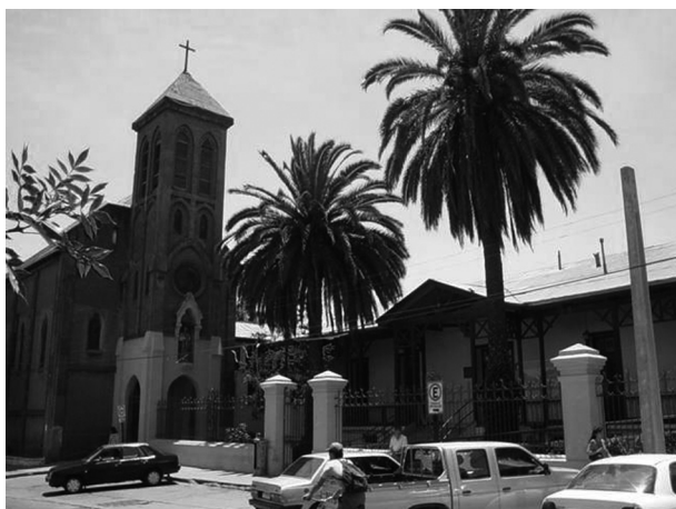
Figura 2. Fachada principal del hospital y su Capilla.
